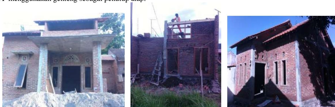
Gambar 4. Tampilan Fisik Bangunan A, B dan C
