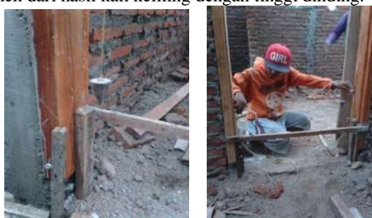
Gambar 5. Lot dan Selang yang Digunakan Tukang Bangunan
